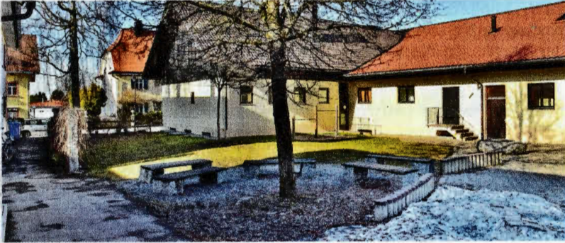
Die Lücke im Schulhof (Bildhintergrund links) zur Straße hin wird mit einer Betonwand geschlossen. Davor ist eine Bühne mit kleinem Vordach geplant.
