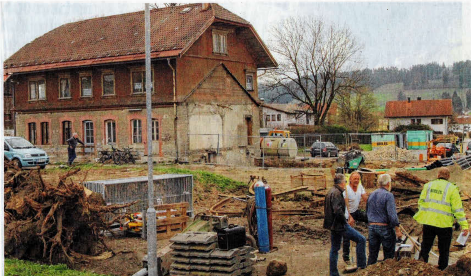
Das Gelände hinter dem Bahnhof wird derzeit für eine Bebauung vorbereitet. Hier soll das Verkaufszelt für Feneberg entstehen.
