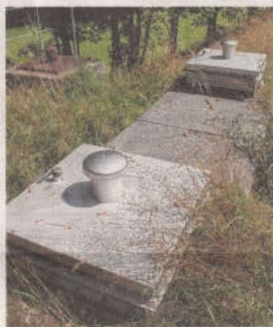
Nur diese drei Abdeckungen sind von außen vom Hochbehälter Sandbühl oberhalb der Schule in Weiler zu sehen. Er stammt aus dem Jahr 1946 und ist sanierungsbedürftig. Foto: Olaf Winkler
